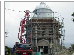
灯台建築・補修
