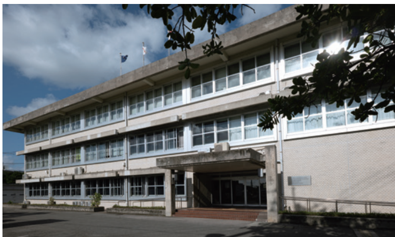
石垣港湾合同庁舎
