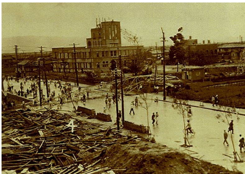
▲室戸台風の被害(1934年(昭和9年)9月21日：大阪測候所を写したもの)
