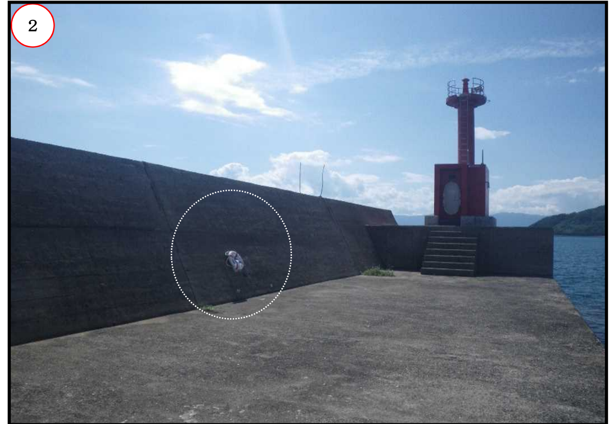
湊浜漁港（岸壁）「漁港奥側」
