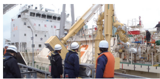
危険物専用岸壁の点検（釧路）
