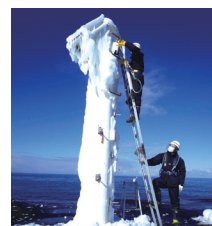
灯台の着氷除去作業 （積丹町日司港外防波堤灯台）
