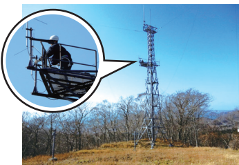
無線通信施設の保守・管理
