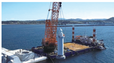
倒壊から復旧した灯台（留萌港西防波堤南灯台）
