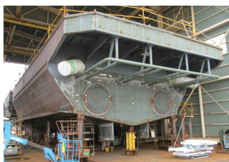
建造中の巡視船
